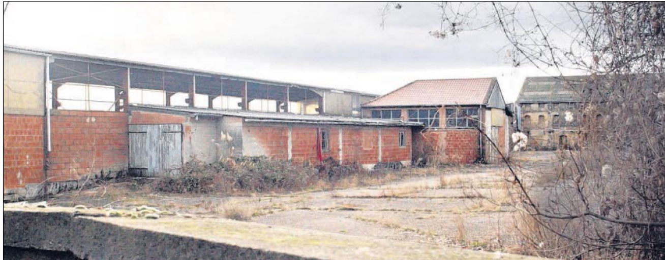
Zum Abriss freigegeben: Ein nichtoffener Wettbewerb entscheidet, wie die neue Bebauung aussehen soll.
